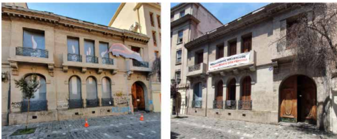
Intervención y limpieza en fachada de Londres 38
