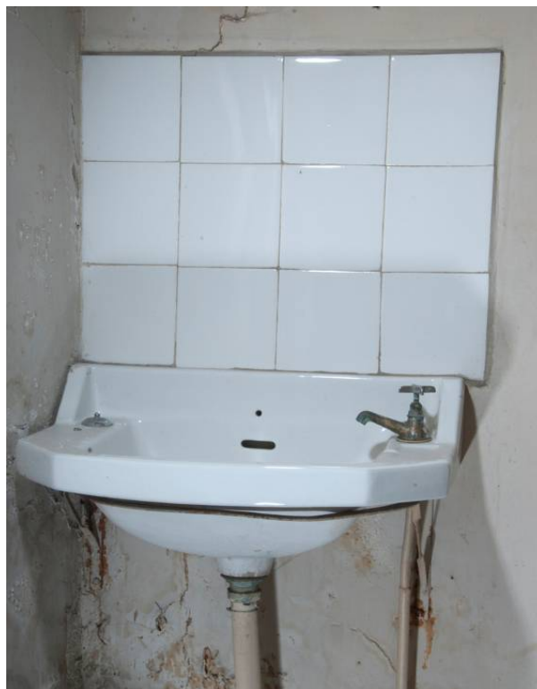
Figura 43: situación actual de la zona del lavamanos
