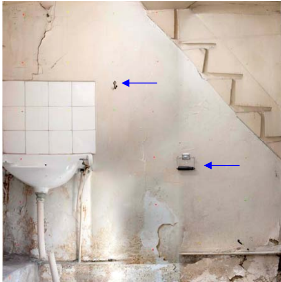
Figura 5: imagen izquierda muro este; imagen derecha muro oeste. Las flechas azules indican la ubicación de los dispositivos enclavados en el muro. La flecha verde, el rasgo dejado por la escalera de servicio una vez que fue desmontada. Nótese los problemas de humedad que presenta el muro este en su base, los cuales están asociados al ducto de agua y se extienden hacia el muro norte; están actualmente activos.
