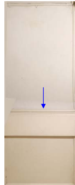
Figura 6: imagen izquierda piso; imagen derecha cielo. Las áreas demarcadas con línea roja discontinúa indican zonas parcialmente cubiertas con cemento. El área demarcada en celeste señala superficie carente de baldosas. La flecha azul indica desnivel en el cielo, en sobre relieve, producto de la presencia in situ de uno de los peldaños de la escalera desmontada.
