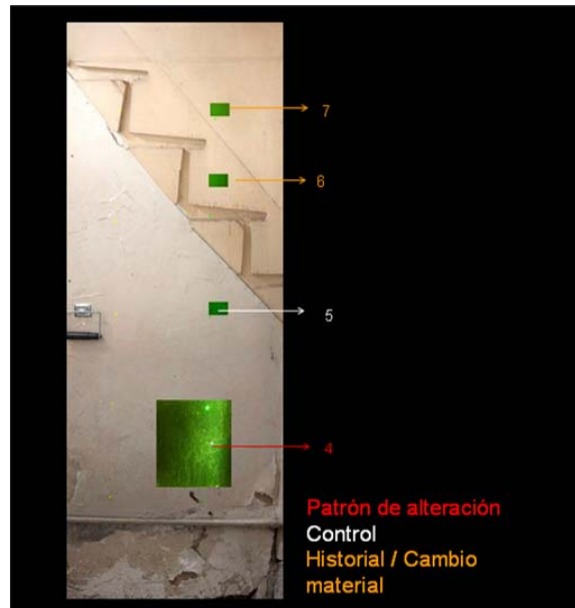
Figura 13: localización de muestras en muro este.
