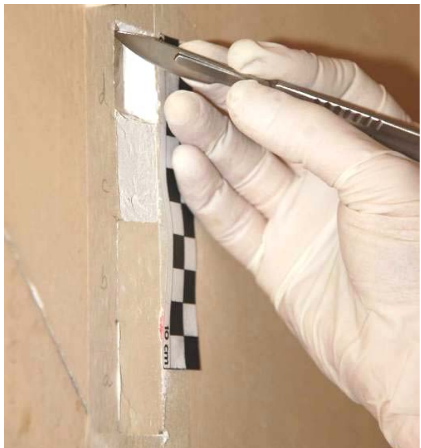
Figura 16: ejecución de la ventana VE1, en el muro este del Baño 2, donde se visualizan los estratos a, b, c y d.
